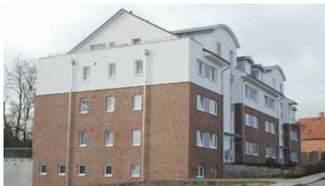
Wohnhaus in der Kirchenstraße
