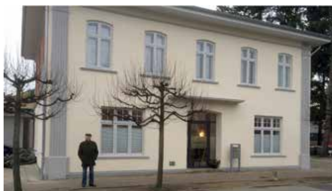
Erhardt Eger freut sich über die gelungene Renovierung
