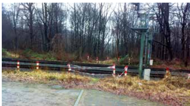
Die Sicherheit des Bahnkörpers am Ende der Anton-Baumann-Straße muss verbessert werden
